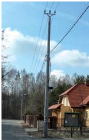
Fot. 9 Linia napowietrzna 15 kV z podwieszoną linią 0,4 kW (przewody izolowane)
