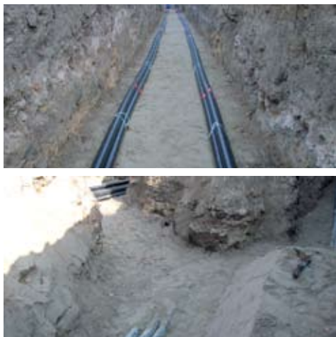
Fot. 5 i 6 Kable 110 kV przed zasypaniem bentonitem i zasypane bentonitem
